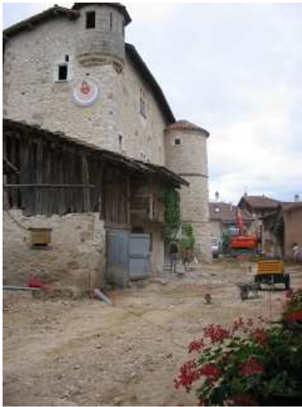
19. Avant ... pendant les travaux
